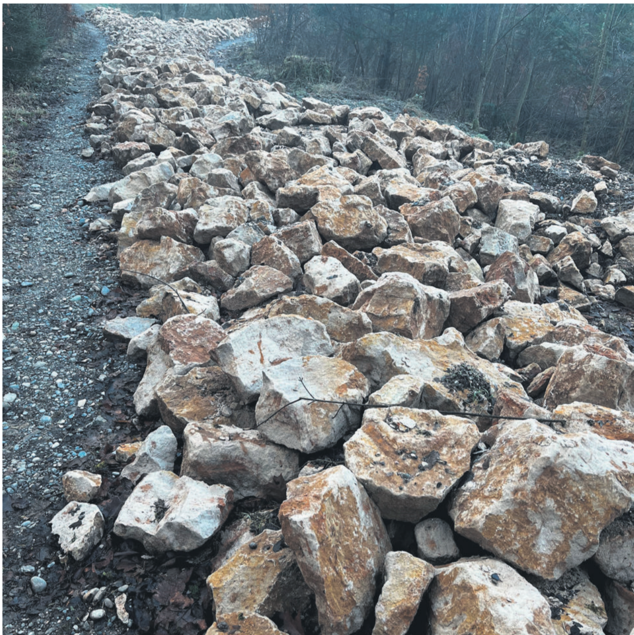
Die Felsbrocken werden voraussichtlich im Januar mit einem mobilen Steinbrecher zerkleinert. Wegen des Wetters kam es zu Verzögerungen.
